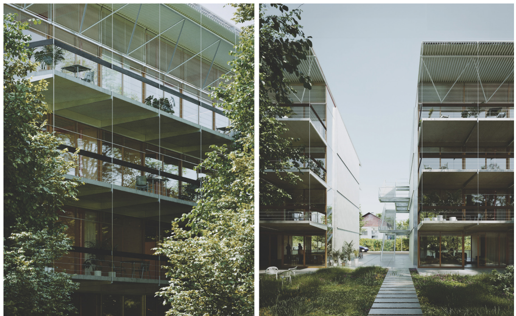
Baubereich S1: Gartenseite (links), Zwischenraum mit Treppenanlage
