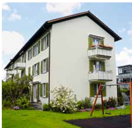
▲ Die Zwinglistrasse vor der Sanierung
